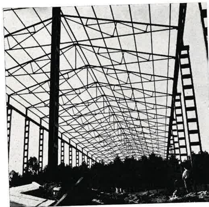
Estructura Nave Gramuro. - PUXEIROS - VIGO
